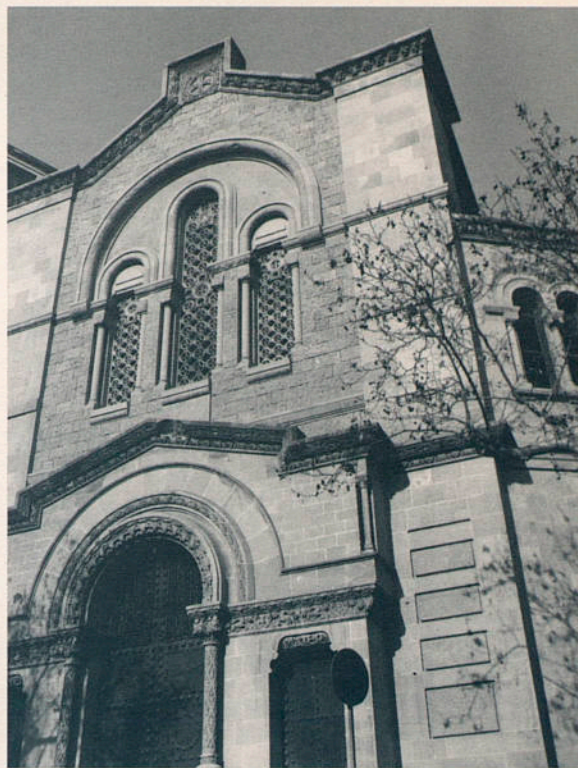
Vista actual de la façana del santuari.
