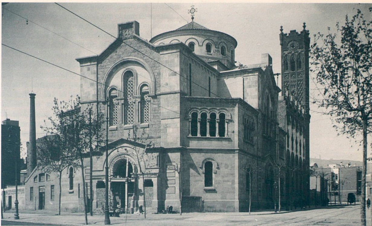
L'edifici vist des de l'avinguda Diagonal poc abans d'enllestir-se les obres.
